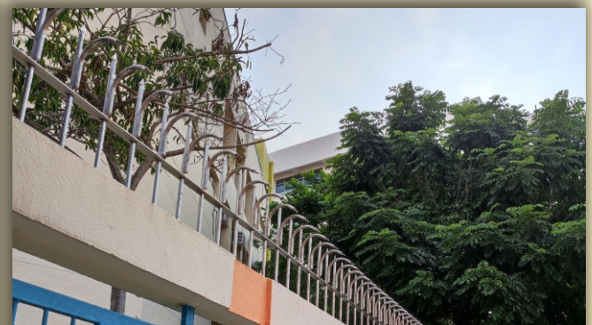
新建設 學校外牆的防盜鐵鉤
